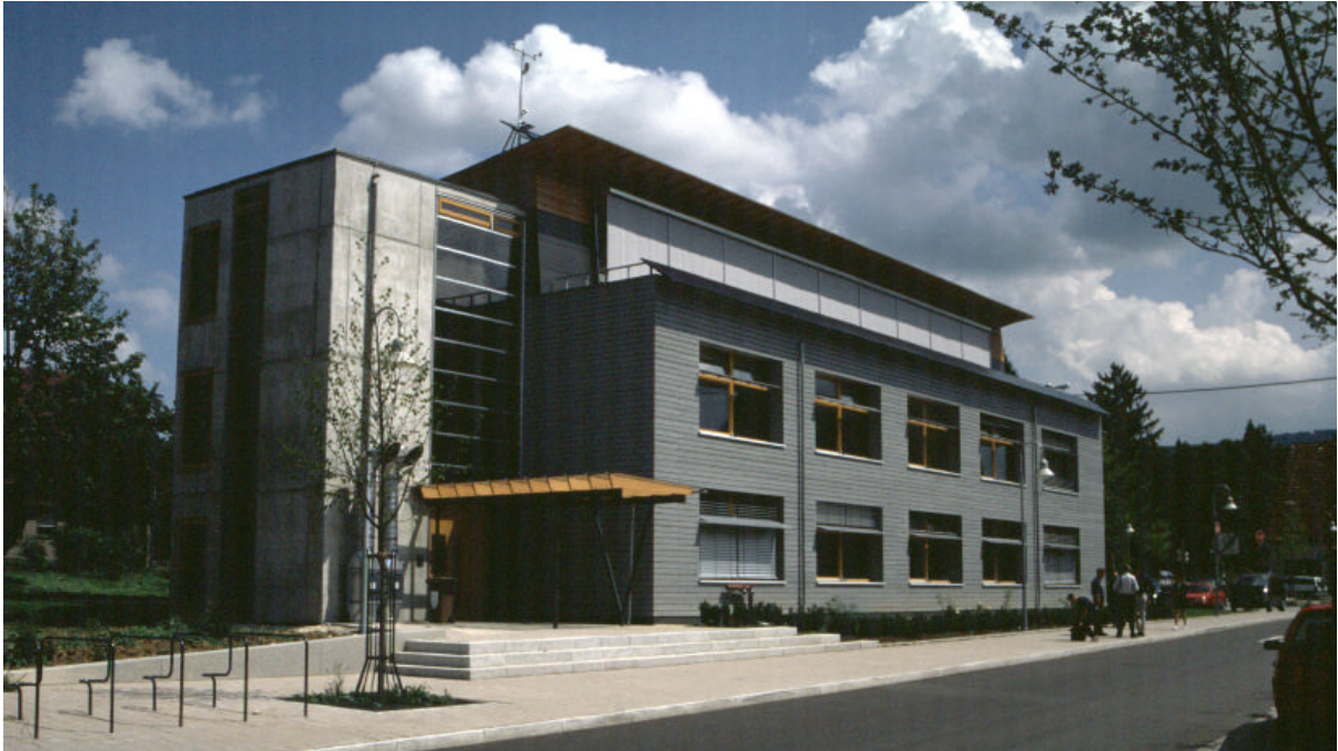
Grafik 4: Das Bürogebäude 'Lamparter' in Weilheim/Teck zählt zu den energetisch Besten in Mitteleuropa; bei gutem sommerlichem Innenklima und weitgehender Tageslichtnutzung (Foto: D. Hennings).
